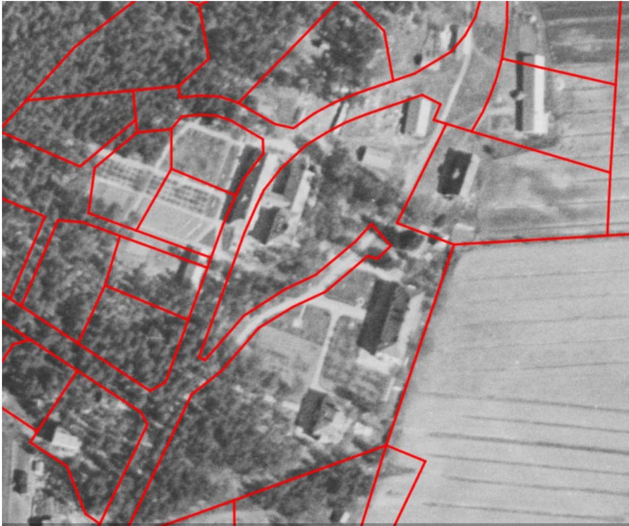
Ilmakuva vuodelta 1960. Kiinteistörajat 2023. Kuvasta ilmenee Pohjanmäentien kohdalta purettu sairaala, josta on jäänyt jäljelle korttelin 10 rakennuspaikan 4 kerrostalo.
