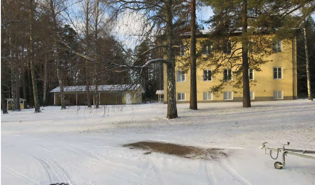
Kortteli 10/4 on asutokäytössä. Pihapiiriin on rakennettu autokatos/varasto
