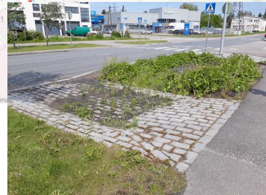
Esimerkki biosuodattimesta. Kuvan suodattimessa kivetty "tasku" karkeamman kiintoaineen erottamiseen. Kuva: AFRY Finland Oy
