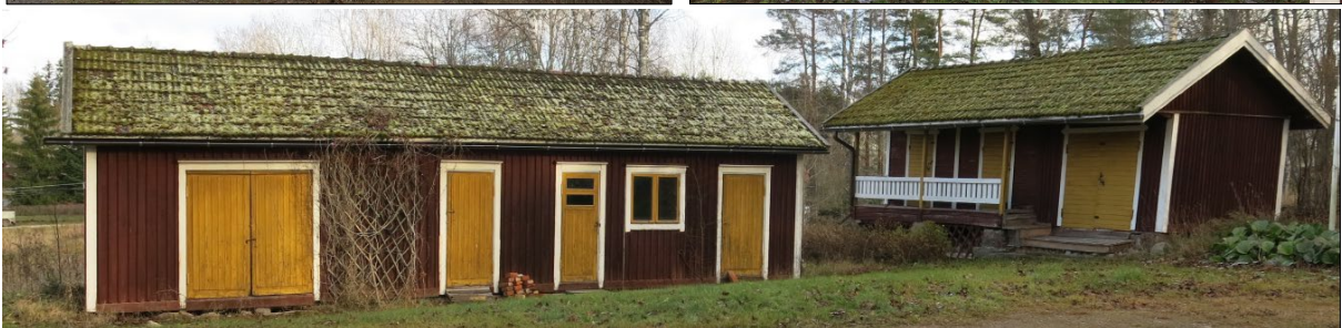
Reitalan päärakennuksen rakennuslupa on myönnetty v.1920. Piharakennukset ovat samalta ajalta. Ait- tarakennus on ollut aiemmin suurempi. Huonokuntoinen lautarakenteinen osa purettiin rakennuslupa- päätöksellä v. 2006 ja jäljelle jäi hirsirakenteinen aittaosa.
